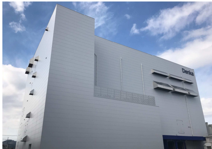
<インフルエンザワクチン原液製造新棟>
