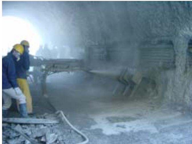
写真1：供試体作製状況
