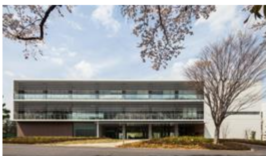
(デンカイノベーションセンター本館)
