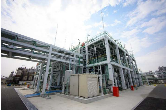
スネクトン製造プラント外観
