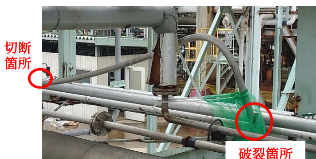
【図 5. 破裂配管】
