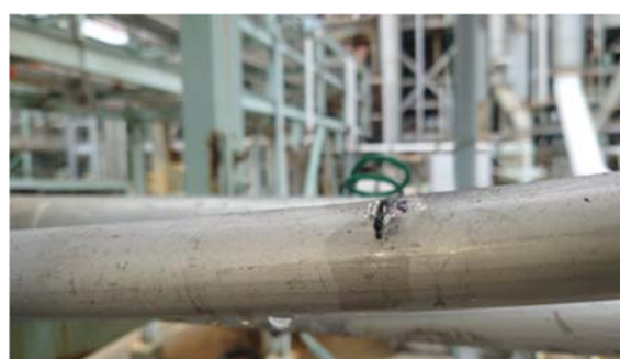
【図 6. セーバーソーでの切断箇所】
