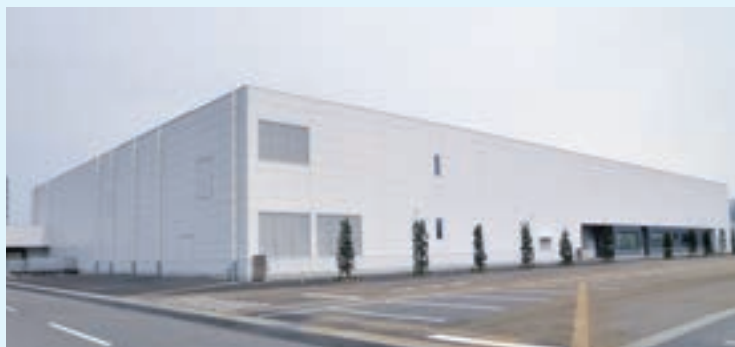
鏡田工場新製造棟の外観
