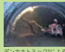
デンカナトミック®によるトンネル吹き付け工事
