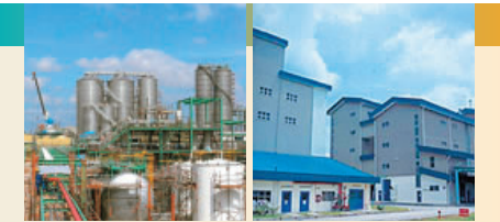
プラントの建設状況 (DSPL) 増設される溶融シリカ工場 (DAPL)
