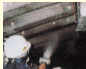
再アルカリ化施工
