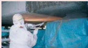
高耐久性・高効率施工を実現する補修用吹付材「スプリード」
