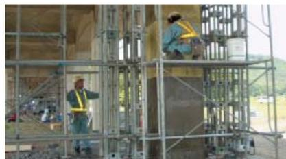
東北新幹線橋脚ひび割れの緊急補修工事
