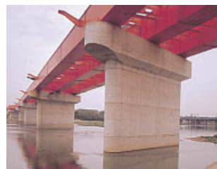
グラウト用無収縮材が使用された橋梁
