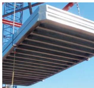
サクセム®を使用した橋桁
