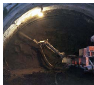
デンカナトミック®によるトンネル吹付け工事
