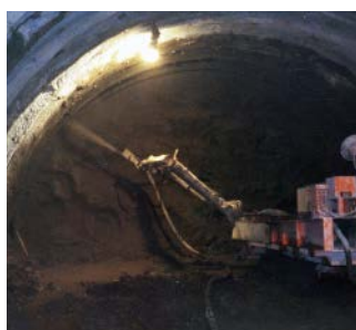
デンカナトミック®によるトンネル吹付け工事
