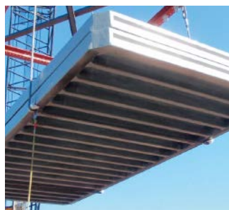
サクセム®を使用した橋桁
