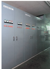
電源ボックス組立
