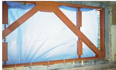
プレス耐震補強施工
