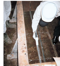
二次製品型枠組立
