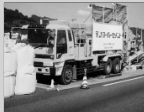
床版上面増厚施工
