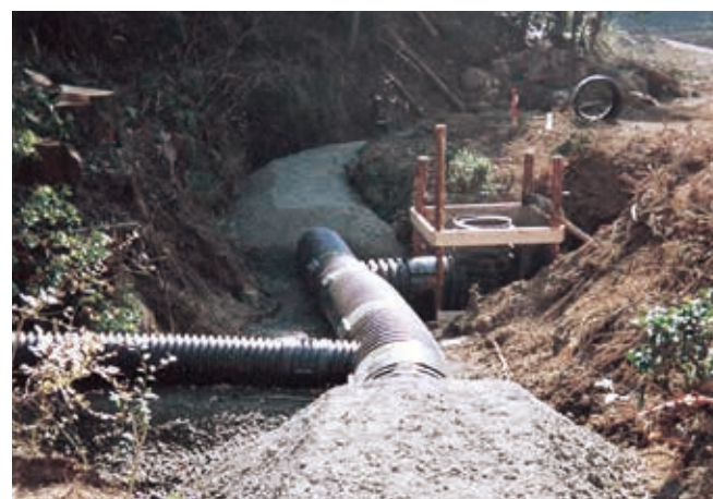
土捨場防災暗渠工事
