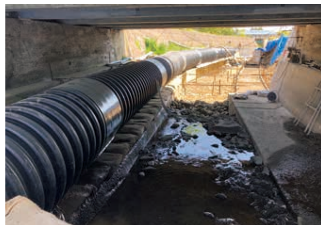
河川改修仮排水工事
