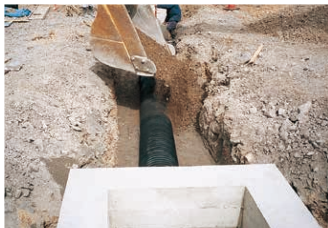
NEXCO用排水管工事
