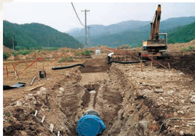
圃場整備小排水路管路化工事
