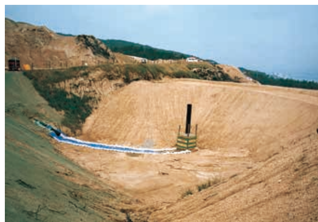
土地造成堅形集排水管工事
