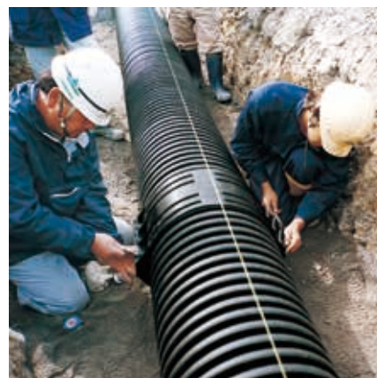
リング管ソケットの取付け
