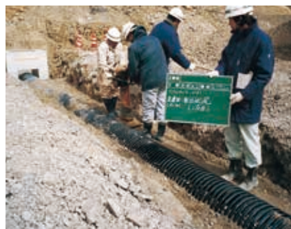
NEXCO用排水管工事
