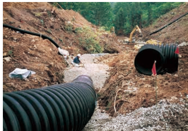
土地造成防災暗渠排水工事
