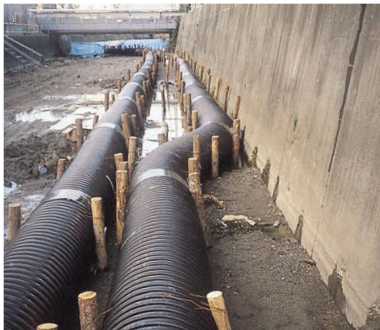
河川改修(水路切り直し)工事
