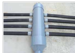
③ 全箇所同様に施工する。
