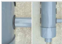
② ゴムに滑剤を塗り、マーキングが隠れるまで管を挿入。
