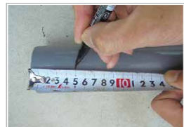
① 管端部から5cmの箇所にマーキングする
