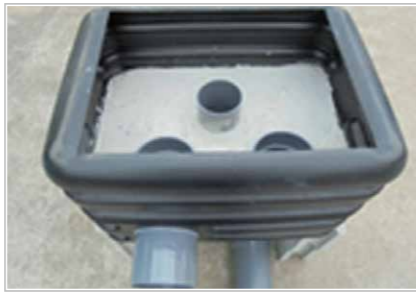
⑤ マス開口部天端からマイナス19～20cm下がりまで、モルタルを打設する
