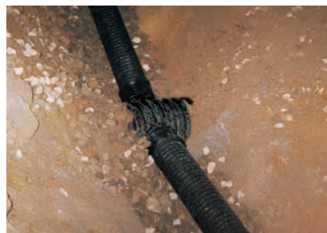
トンネルセントダードレン横断管接続
