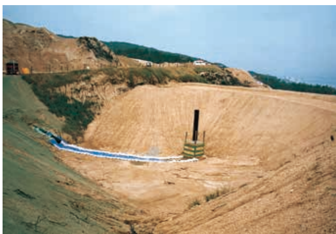
土地造成堅形集排水管工事
