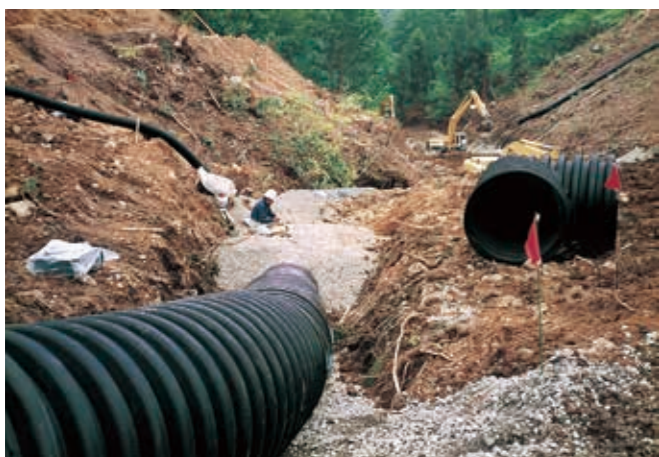
土地造成防災暗渠排水工事
