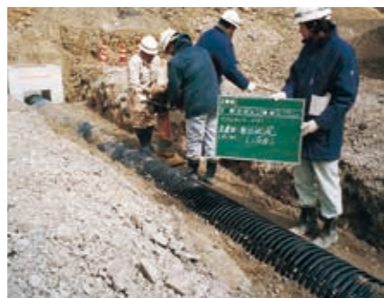
NEXCO用排水管工事
