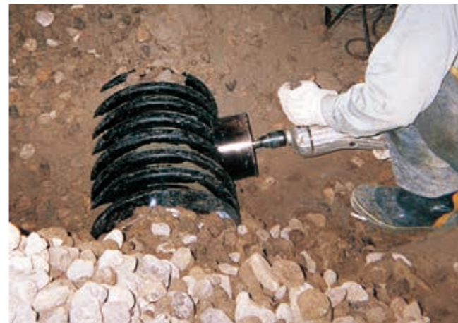
トンネルセントダードレン ゴム支管用穴開け作業
