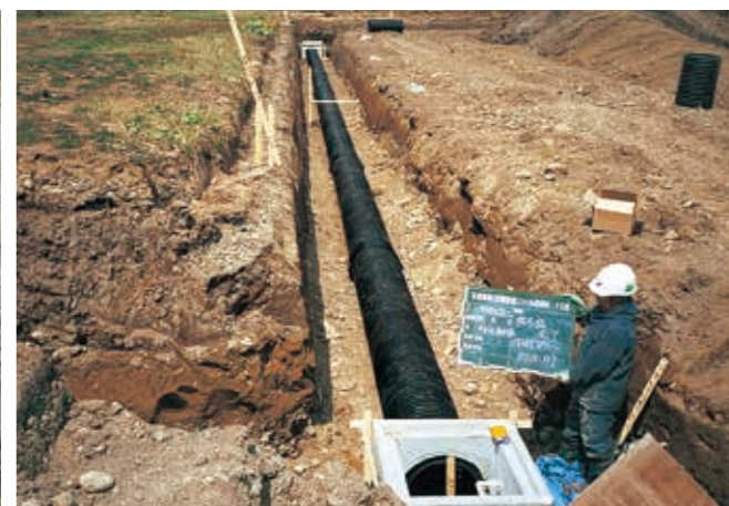
小排水路の管路化工事
