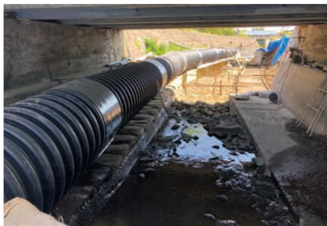
河川改修排水工事
