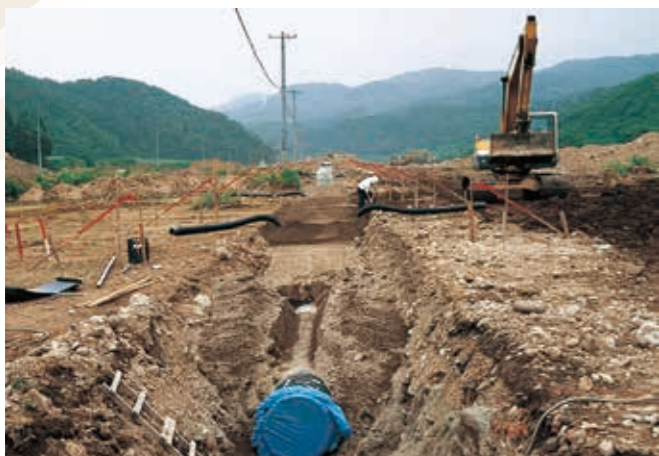
圃場整備小排水路管路化工事
