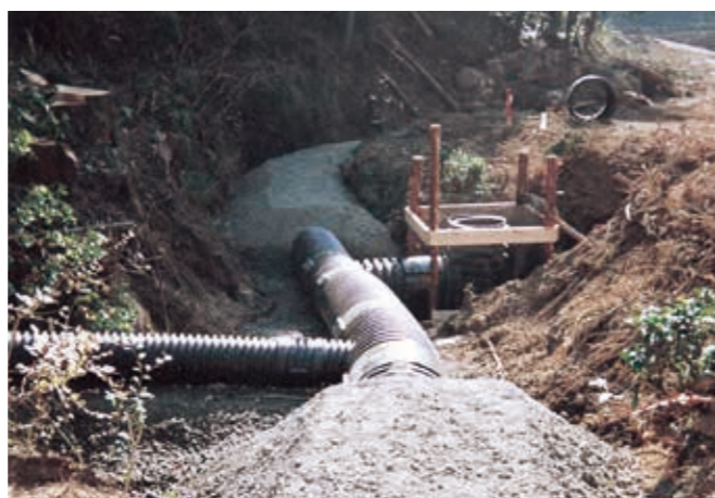
土捨場防災暗渠工事
