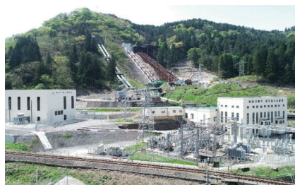
新姫川第六発電所（2022年送電開始）
