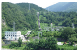
大網発電所（外観）
