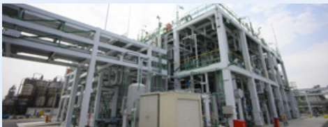
スネクトン製造プラント外観
