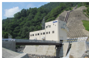
新青海川発電所（2021年送電開始）
