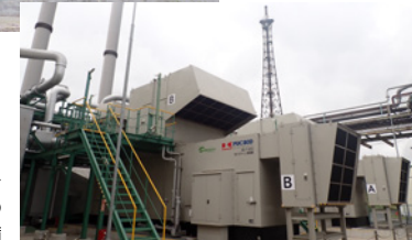
2022年に運転を開始した千葉工場の高スタービン発電設備
