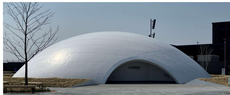
大阪・関西万博にて「CUCO-SUICOMドーム（サステナドーム）」（鹿島建設施工）の躯体の一部に使用された「CUCO-SUICOMショット」に当社の炭酸化混和材「LEAF®」を使用
