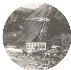
青海川発電所 (新潟県)
