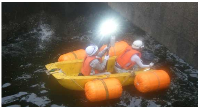
2人乗りボートによる作業状況
