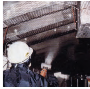
大阪市(大阪城平成の大改修、躯体再アルカリ化)
