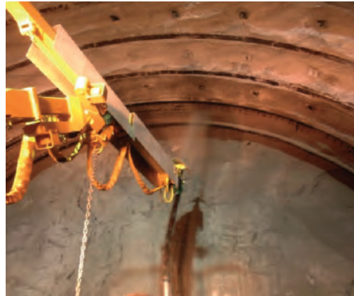
コンクリート吹付け状況
