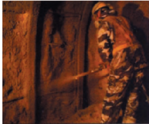
モルタル吹付け状況
