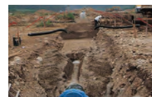
圃場整備小排水管路化工事
