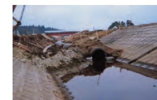
河川改修排水工事
