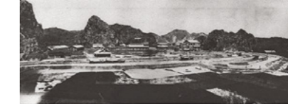
印度支那電化工業チャンケン工場の全景(当時:仏領インドシナ、現:ベトナム)
