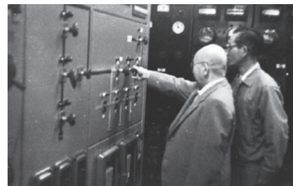
東北電力から受電する様子
