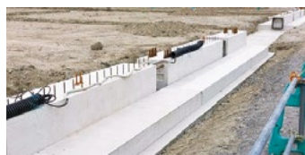
CUCO®-建築用プレキャスト部材を適用した、イベントホール棟の基礎部材 (提供:竹中工務店)
