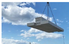
CUCO®-建築用プレキャスト部材を適用した、イベントホール棟の基礎部材 (提供:竹中工務店)
