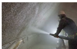
CUCO®-SUICOMショットの吹きつけ作業(提供:鹿島建設)
