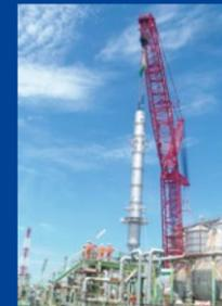
高所での吊り上げ作業を伴った反応器の新設
