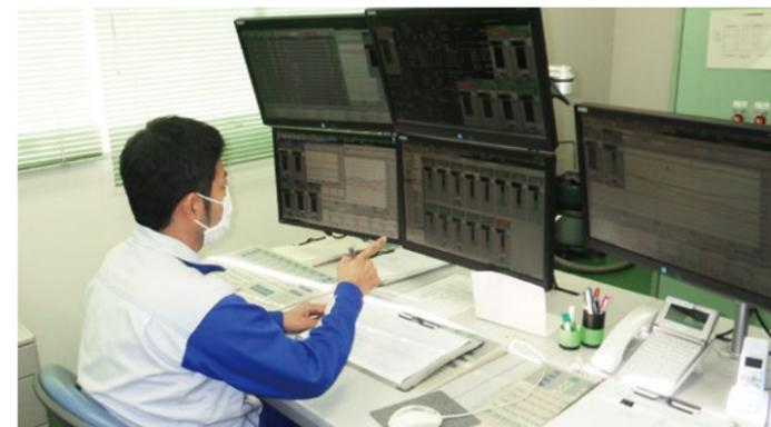
プラントの運転をつかさどる制御システム「DCS (Distributed Control System)」」。操作室では、常に監視と調整が行われている。
