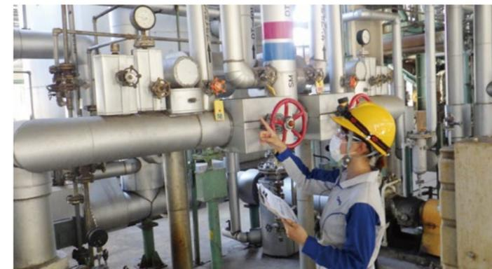
プラント内のポンプの吐出圧力を確認する作業員。現場での経験を積み重ねることが人財育成につながっている。
