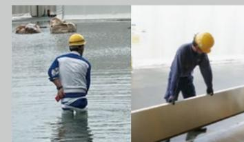
工場内は腰まで浸水(左)。緊急対応として止水板を設置した(右)。
