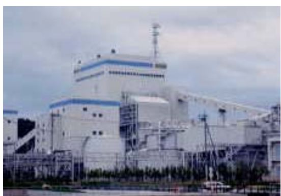
北陸電力 七尾大田火力発電所 外壁材
