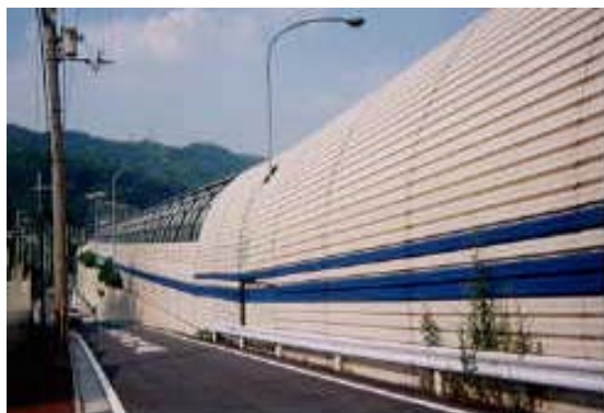
名神高速道路 防音壁
