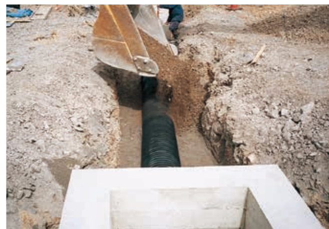
NEXCO用排水管工事
