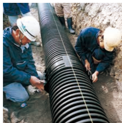
リング管ソケットの取付け
