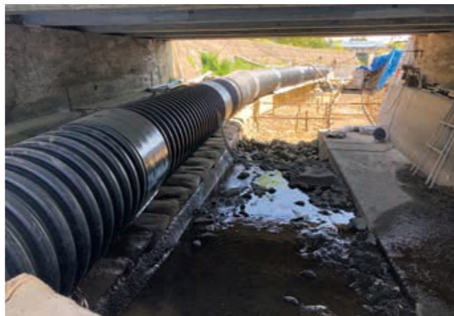
河川改修排水工事
