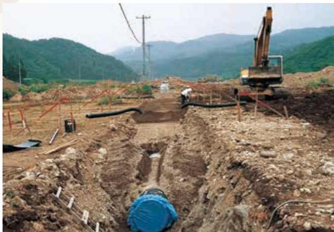
圃場整備小排水路管路化工事
