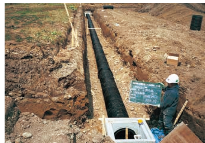
小排水路の管路化工事
