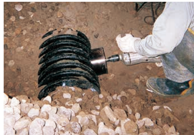
トンネルセントラードレン ゴム支管用穴開け作業
