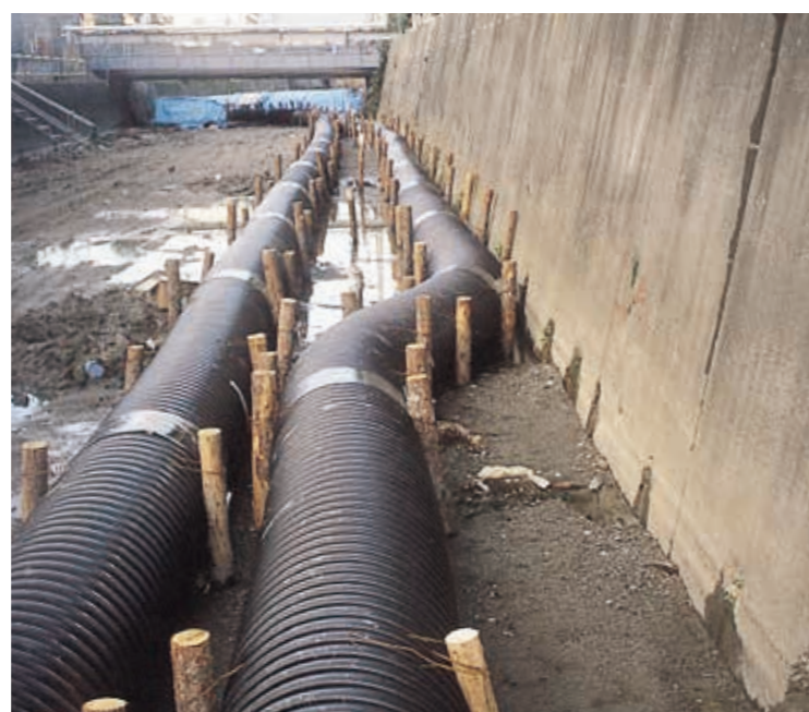
河川改修(水路切り直し)工事
