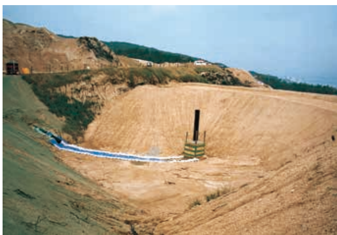
土地造成堅形集排水管工事
