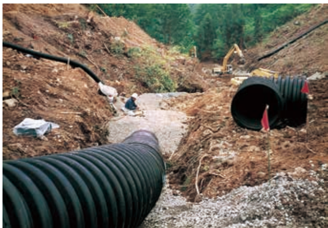
土地造成防災暗渠排水工事
