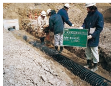
NEXCO用排水管工事
