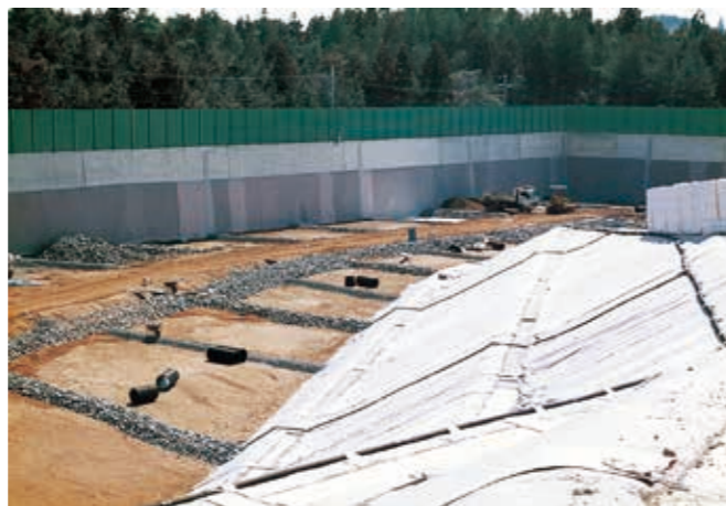
一般廃棄物処理場浸出集排水・ガス抜き管工事
