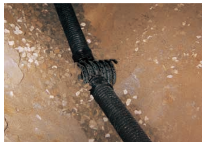
トンネルセントラードレン横断管接続
