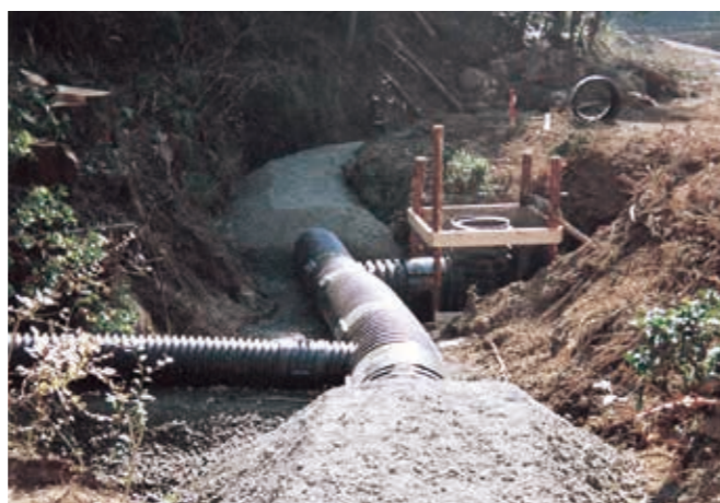
土捨場防災暗渠工事
