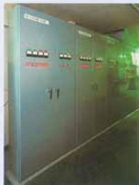
配電盤の組立て
