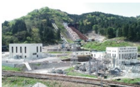
于2022年4月开始运行的黑部川电力株式会社的新姬川第六发电站（左侧为新姬川第六发电站，右侧为姬川第六发电站）
