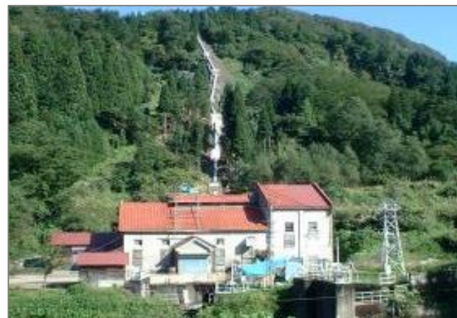
9 日本海川第3发电站
