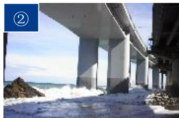
北陆自动车道 亲不知海岸 高架桥/电化学脱盐方法
