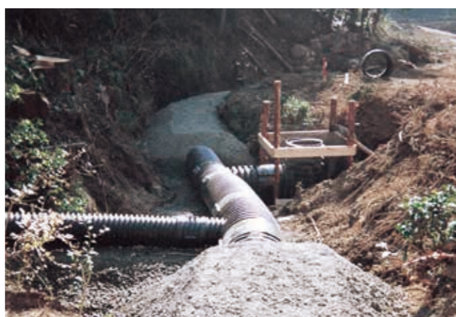
土捨場防災暗渠工事
