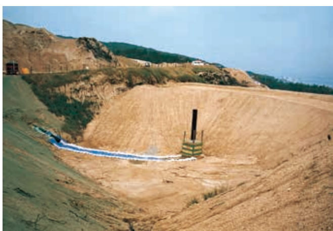
土地造成堅形集排水管工事
