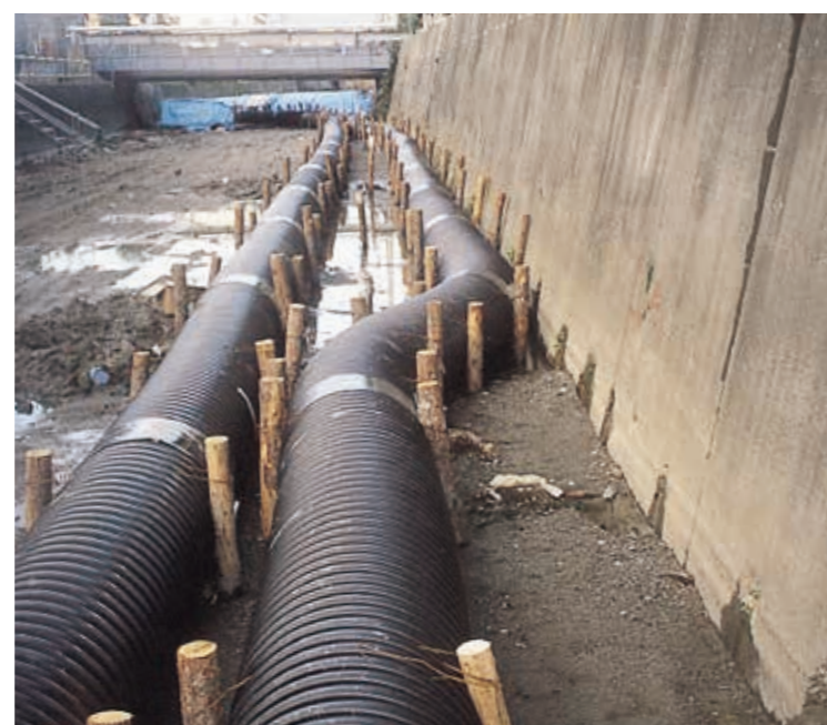
河川改修(水路切り回し)工事
