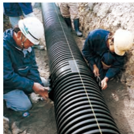
リング管ソケットの取付け
