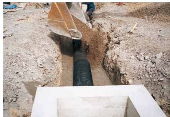
NEXCO用排水管工事
