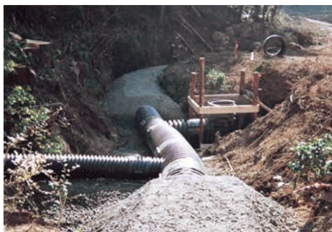
土捨て場防災暗渠工事
