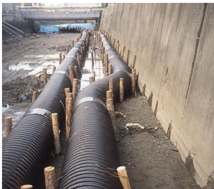
河川改修(水路切り直し)工事
