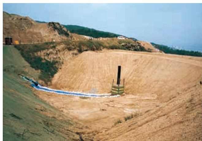
土地造成堅形集排水管工事
