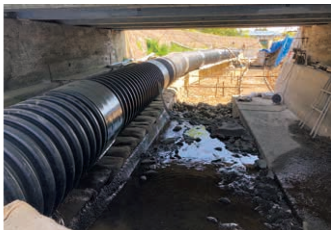
河川改修仮排水工事
