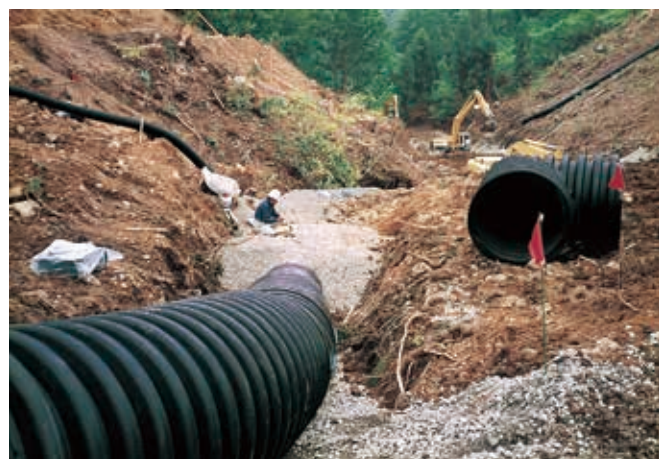
土地造成防災暗渠排水工事
