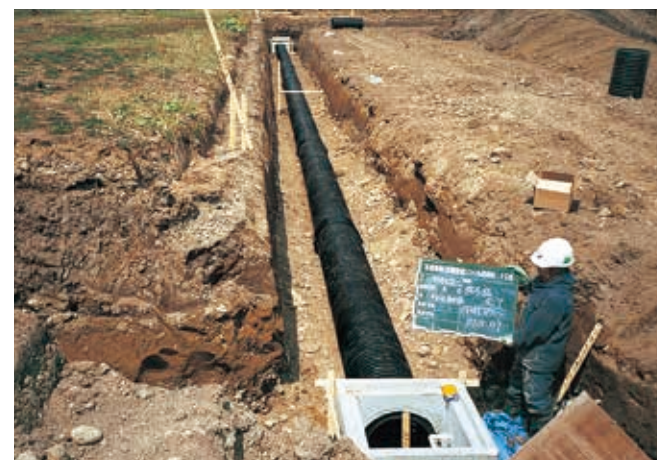
小排水路の管路化工事
