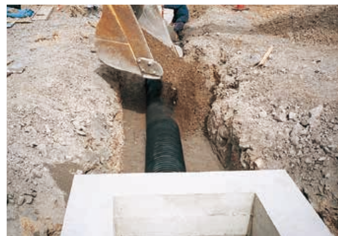
NEXCO用排水管工事
