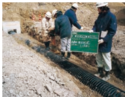
NEXCO用排水管工事
