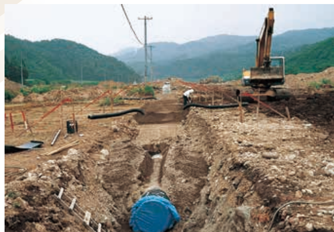
圃場整備小排水路管路化工事
