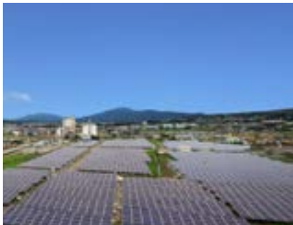
电化涩川太阳能发电设施
