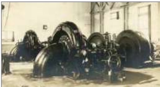
小滝川发电站的混流式水轮机转轮（建设当初）
