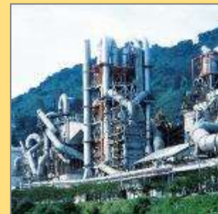
「水泥」 水泥厂循环系统
