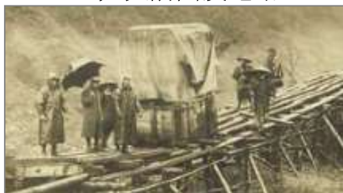
大所川发电站在建时搬运发电用变压器
