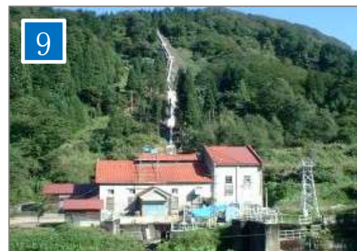
海川第3发电站
