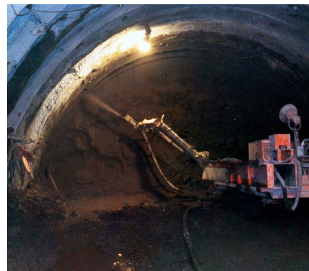
采用DENKA NATMIC进行隧道混凝土喷射施工
