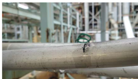
【図 6. セーバーソーでの切断箇所】
