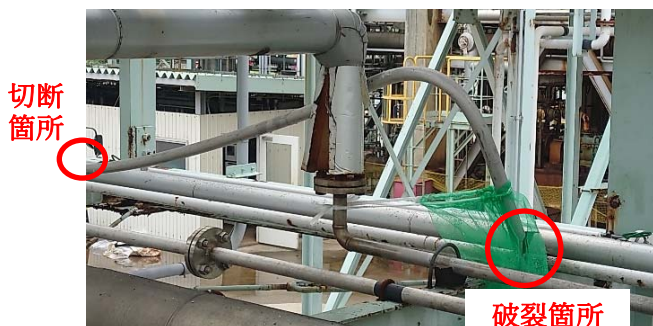
【図 5. 破裂配管】
