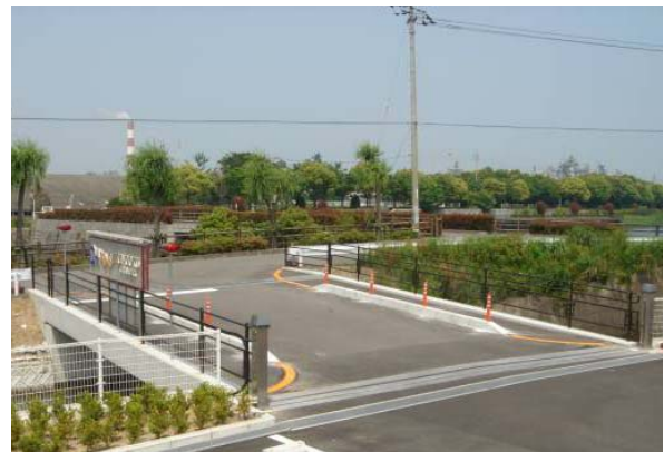
完成したアクアタウン橋梁
