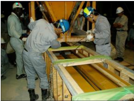
サクセム桁打設の様子
