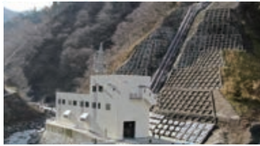
新青海川発電所
