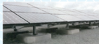
太陽光パネルの基礎ブロックをCO 2 -SUICOM ® により製造した例
