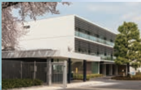
昨年4月に竣工した デンカイノベーションセンター本館
