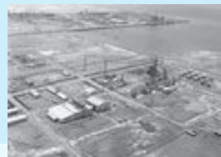
開設当初の千葉工場
