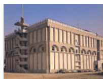
膨張材「デンカCSA」が使用された建築物
