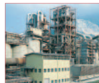
日本海側最大規模を誇るセメント工場(青海工場)
