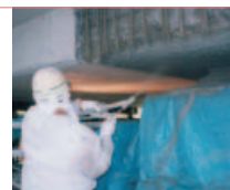
補修用吹付材「デンカスプリード」施工現場
