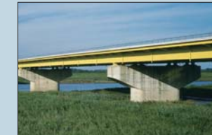
無収縮材「ハイプレタスコン」で補強された橋脚
