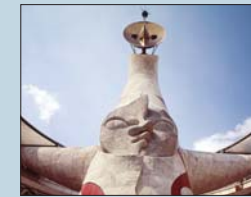
膨張材「デンカCSA」が使用された「太陽の塔」
