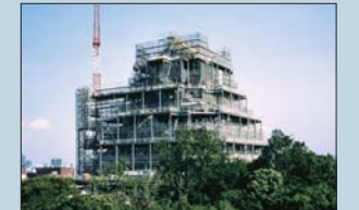
「デンカテクノクリートシステム」が採用された大阪城改修工事
