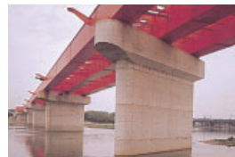
クラウト用無収縮材が使用された橋梁
